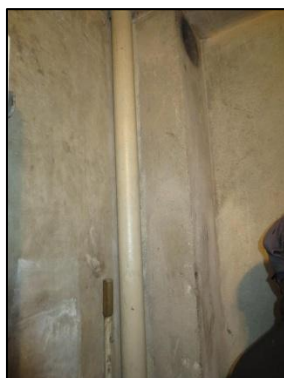
Photo N° 686 AMIANTE CIMENT 1 LORIENT-1er-LOCAL V.O +7 à +8 Conduits de fluide Chute E.P.(Fibres- ciment)
